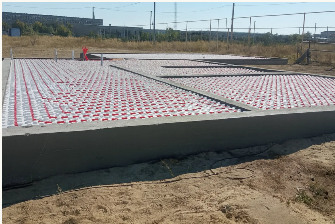
Лисаковск / «Евгений», 198 м² / 2026. Контуры до заливки.
