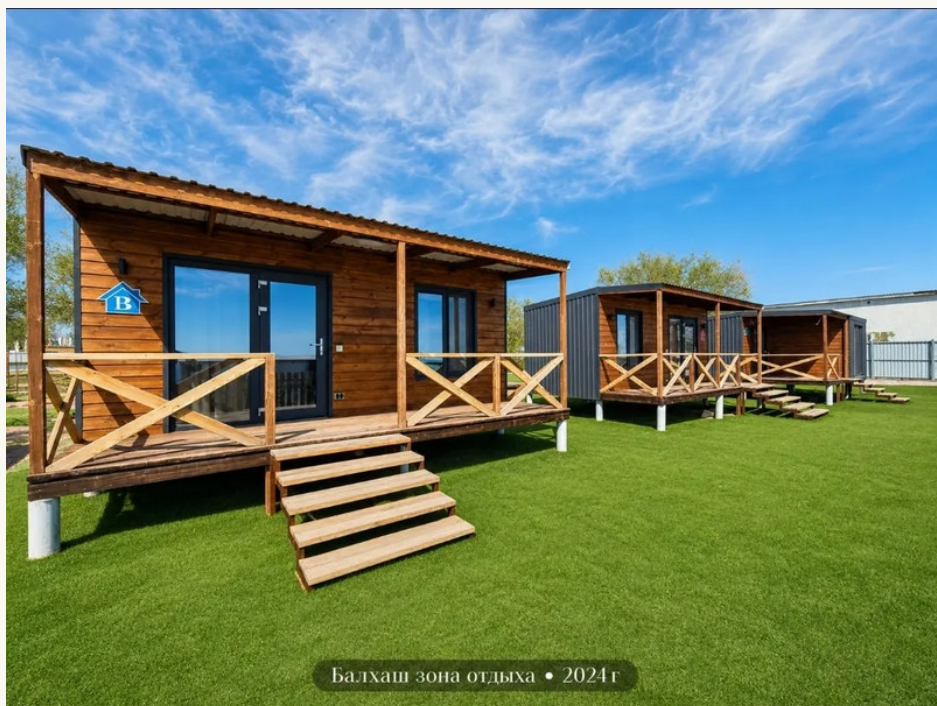
Балхаш / 2024. Модульные дачные дома в зоне отдыха.
