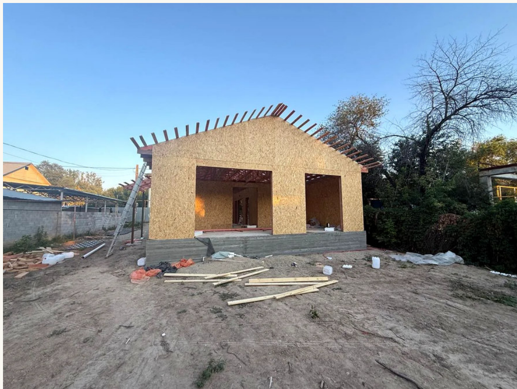
Посёлок Алатау / «Марк», 130 м 2 / 2026. Стропильная система.
