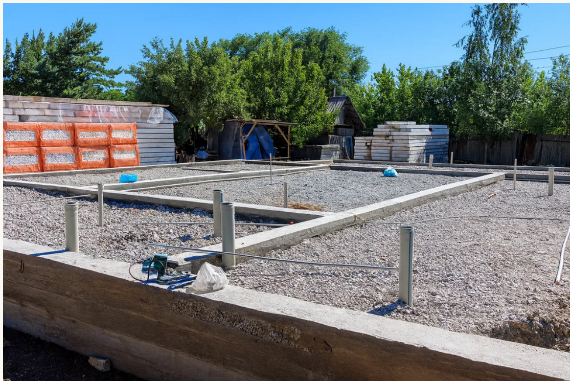
Астана / «Влад» / 2026. Канализационные трубы в основании.
