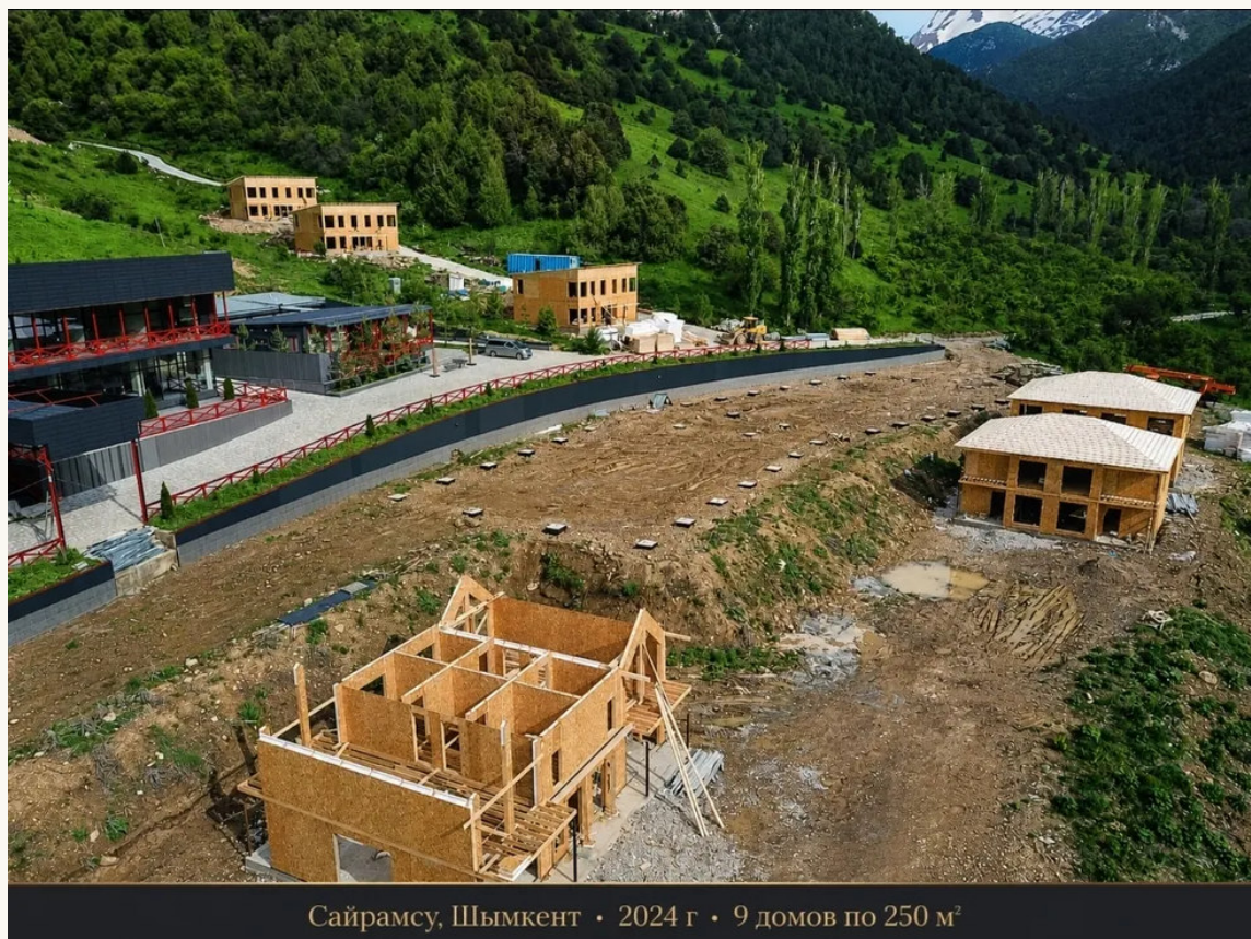
Сайрамсу, Шымкент / 2024. Комплекс на этапе строительства.
