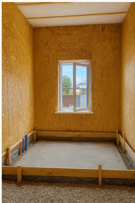
Каскелен / «Пётр», 54 м 2 / 2026. Потолок закрыт плёнкой; подпись фотоархива указывает пароизоляцию.
