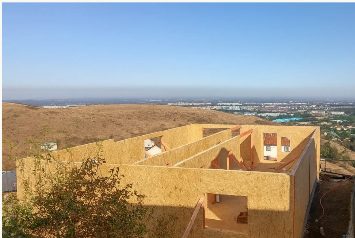
Бесагаш / «Аида», 161 м 2 / 2026. Стены на основании на склоне.
