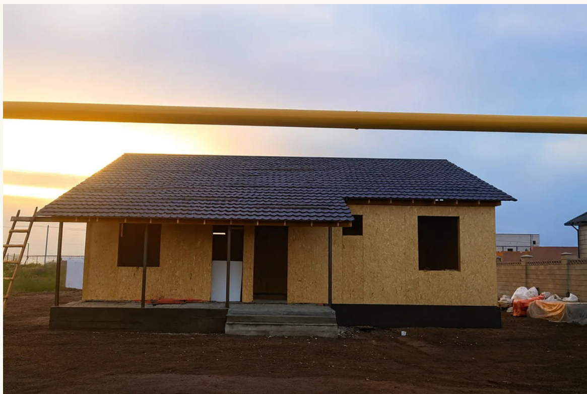
Астана / «Данияр», 130 м² / 2026. Коробка под кровлей.
