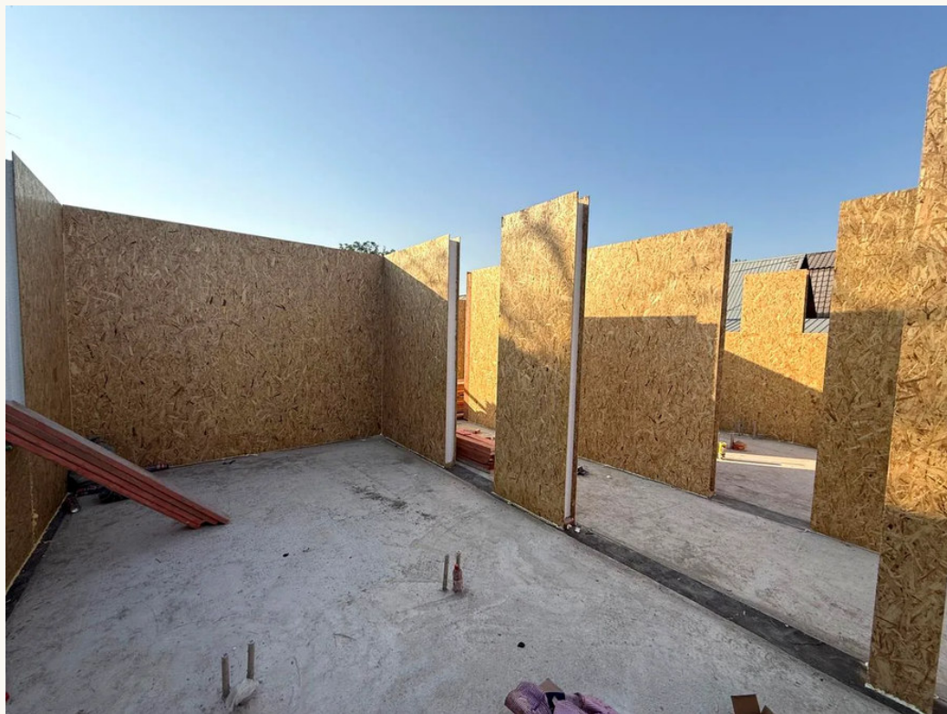
Посёлок Алатау / «Марк», 130 м 2 / 2026. Внутренние стены.
