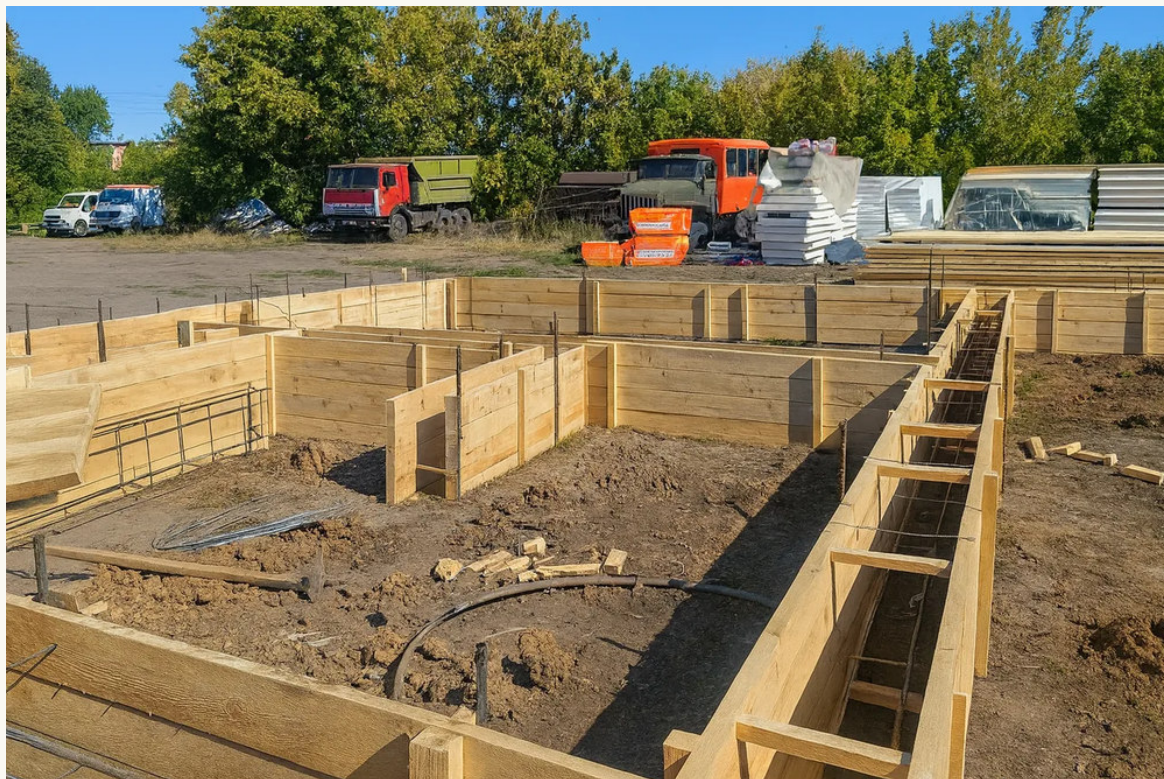
Осакаровка / «Ерлан», 100 м² / 2026. Опалубка и арматура.
