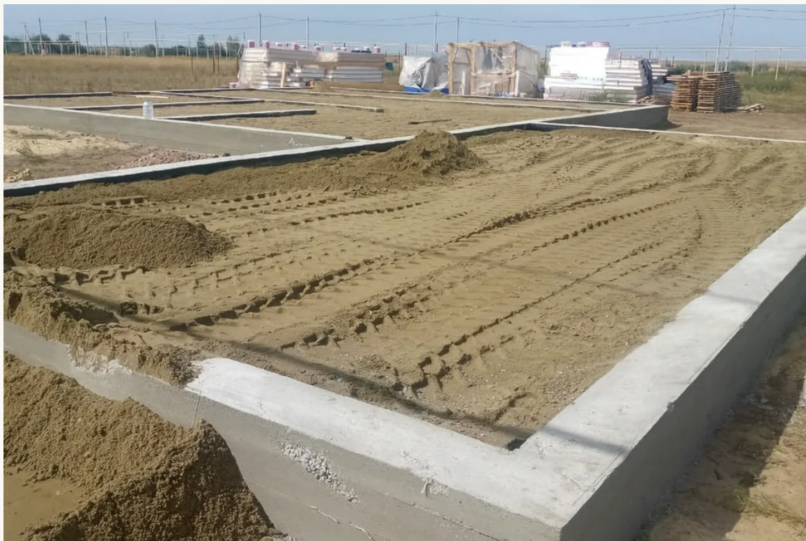
Лисаковск / «Евгений», 198 м² / 2026. Панели на площадке.
