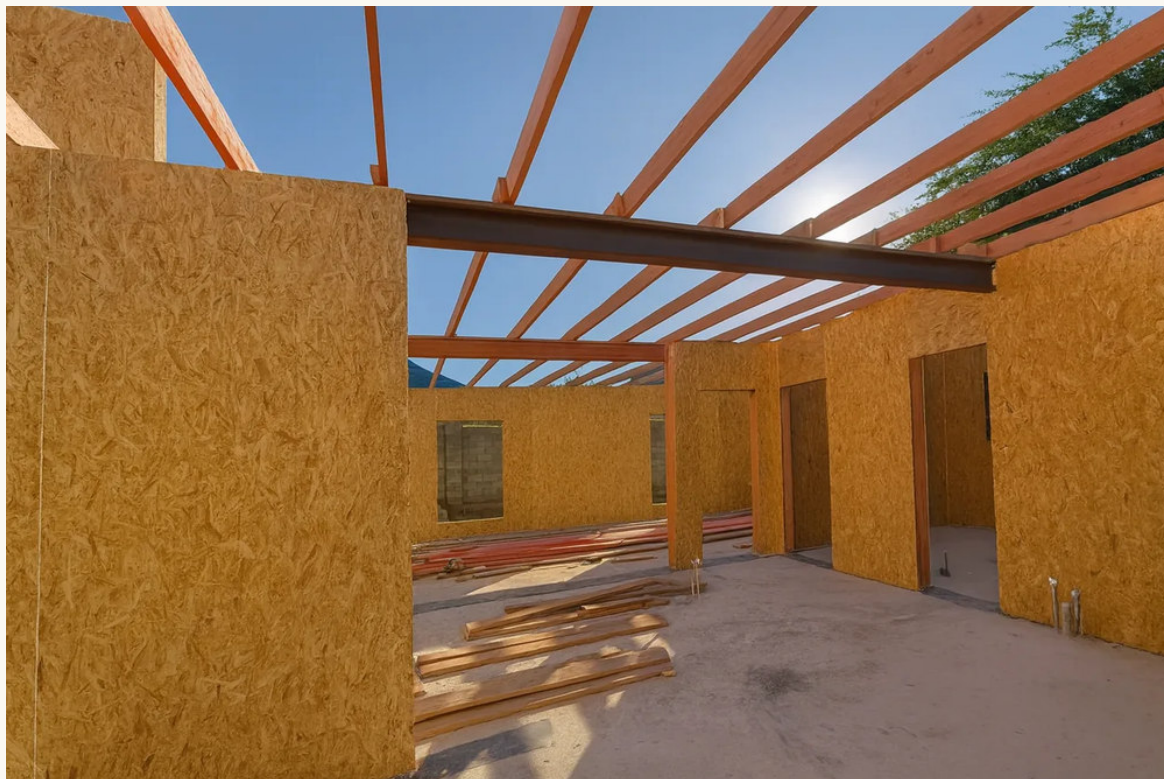
Алматы / «Сатурин», 165 м 2 / 2026. Балки над стенами.
