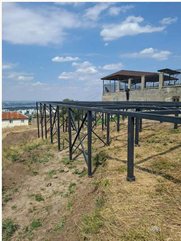
Бесагаш / «Аида», 161 м 2 / 2026. Основание на склоне.
