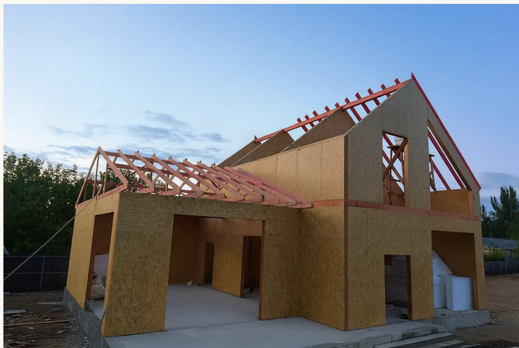
Талгар / «Игорь», 200 м² / 2026. Стропила на двух объёмах дома.
